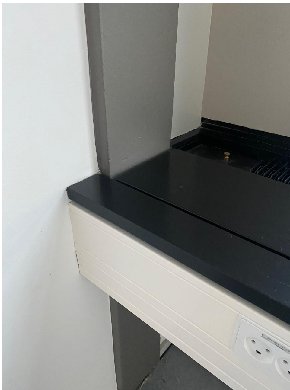
Figur 4 - Forlængelse af vindueskarm med installationskanal nedenunder.
