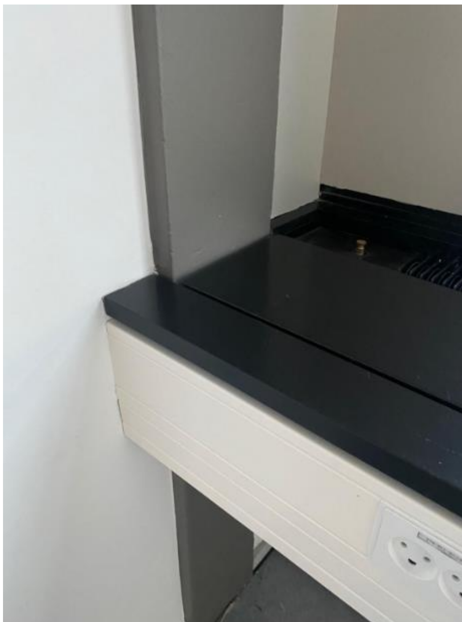
Figur 4 - Forlængelse af vindueskarm med installationskanal nedenunder.
