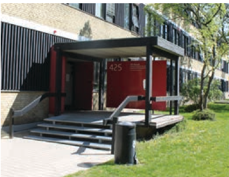
Det karakteristiske overdækkede indgangsparti til DTUs normalbygninger med det røde ankomstskilt Foto: Praksis Arkitekter
