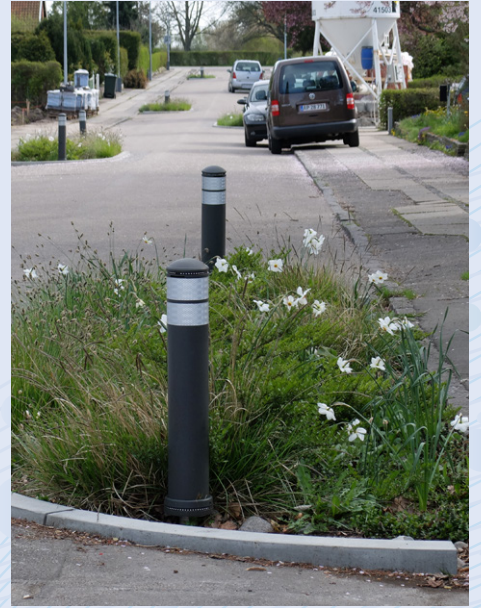
Multifunktionelt regnbed til klimatilpasning og sænkning af trafikshastigheden. Foto: Sara Lerer, DTU Miljø
